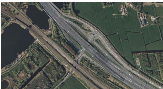
Afslag 2 Diemen Amsterdam-IJburg gaat op in het snelweglandschap van de A1. De afslag volgt het principe van oprijlaan naar de stad door de bomenrijen die langs zowel de A1 als de afslag geplant zijn.
