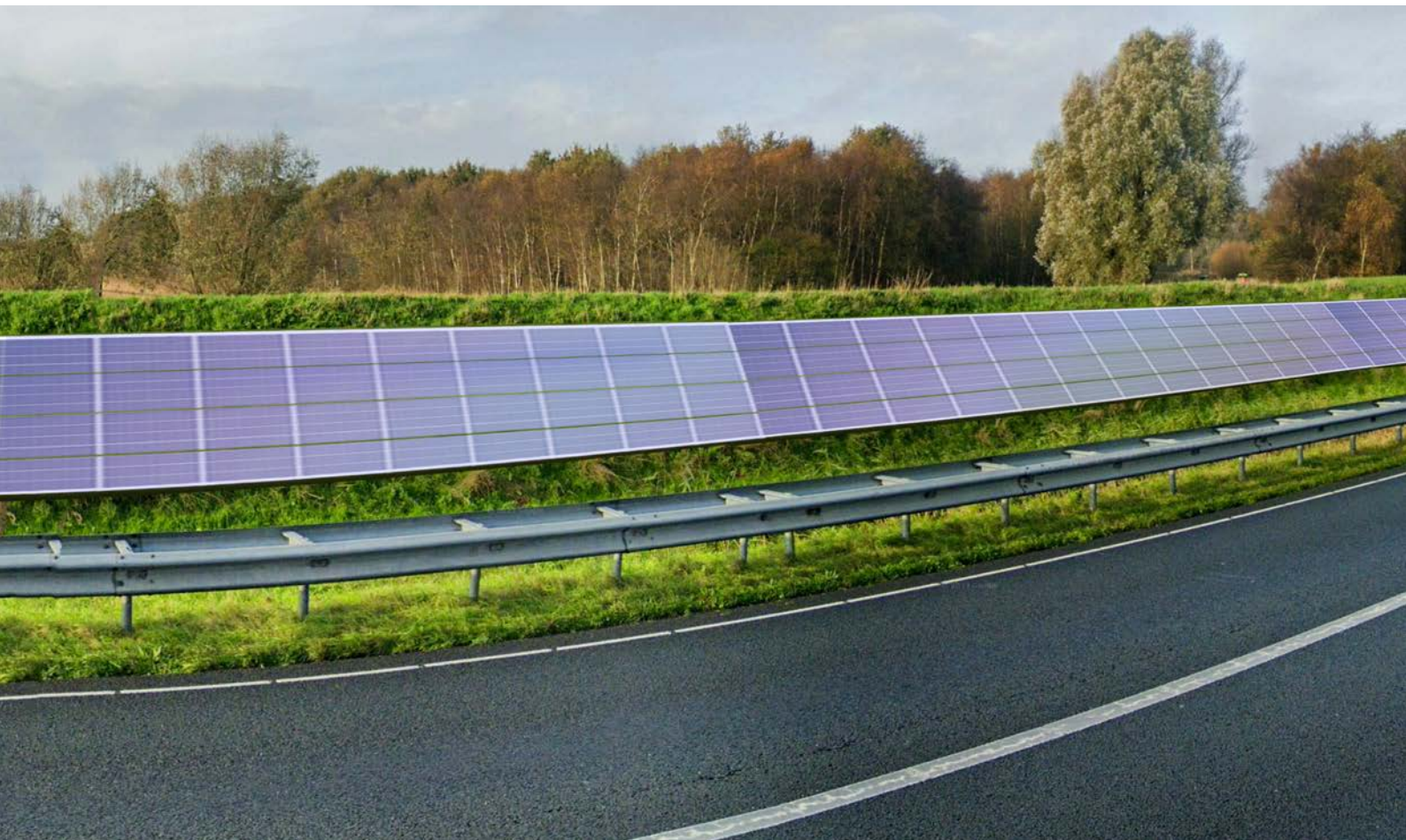
Impressie van een opstelling van zonnepanelen op de bestaande geluidswal van Heiloo
