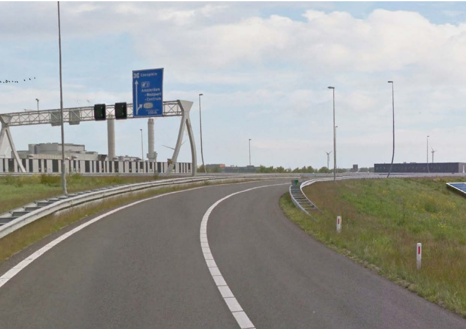
Impressie van zonnepanelen op het talud in het Westelijk Havengebied. Een grote, aaneengesloten opstelling op dit talud in industriële context
